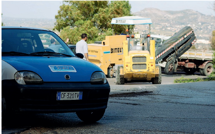
Lavori di riparazione di una condotta idrica
